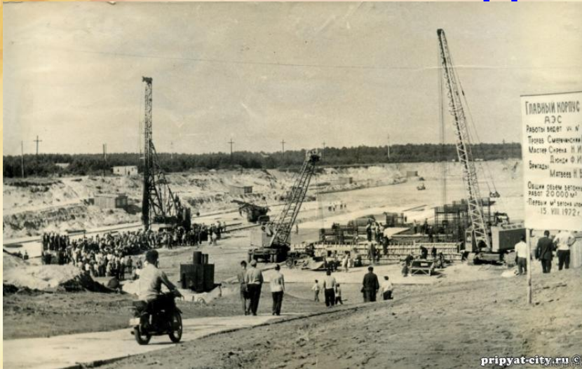
Будівництво Чорнобильської АЕС
