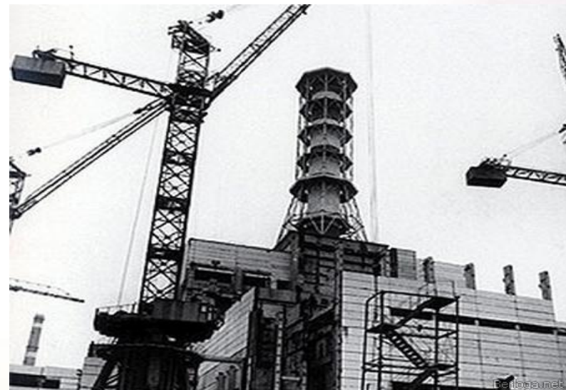
Монтаж верхніх перекриттів 4-го блоку ЧАЕС (1983)
