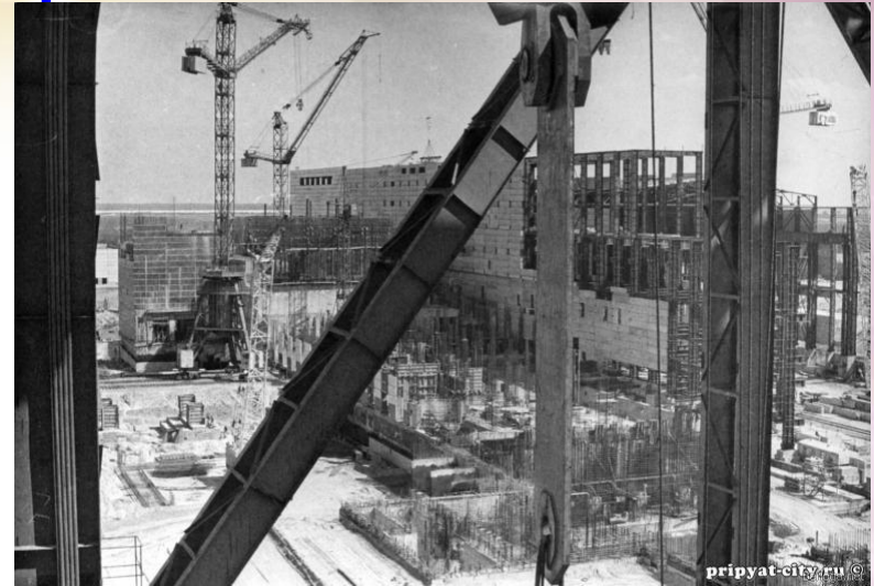
Вид з крану, який монтує реактор
